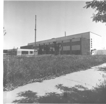
Stația de Tratare a Deșeurilor Radioactive
